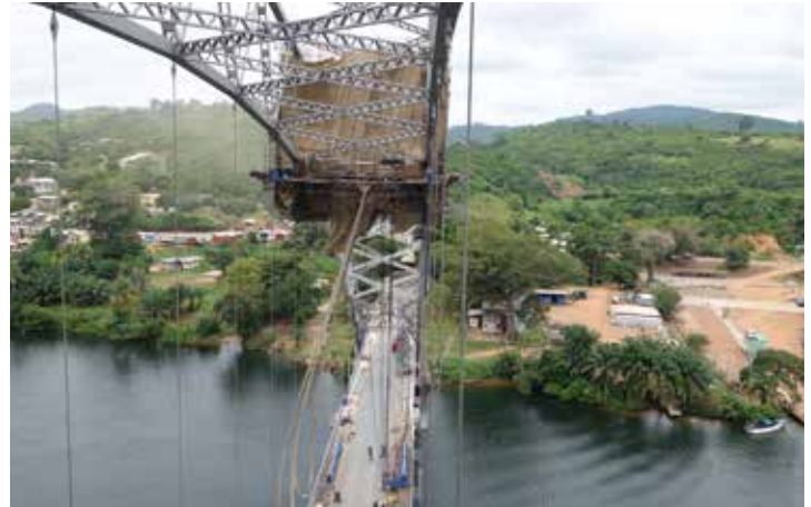
Korrosionsschutzarbeiten am Bogen
