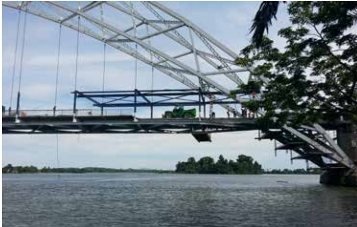
Austausch der Fahrbahnplatte
