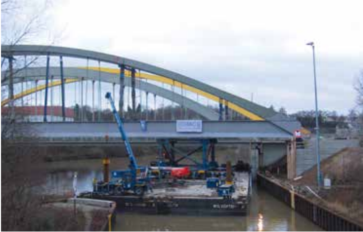
Einschwimmen Stahlüberbau
