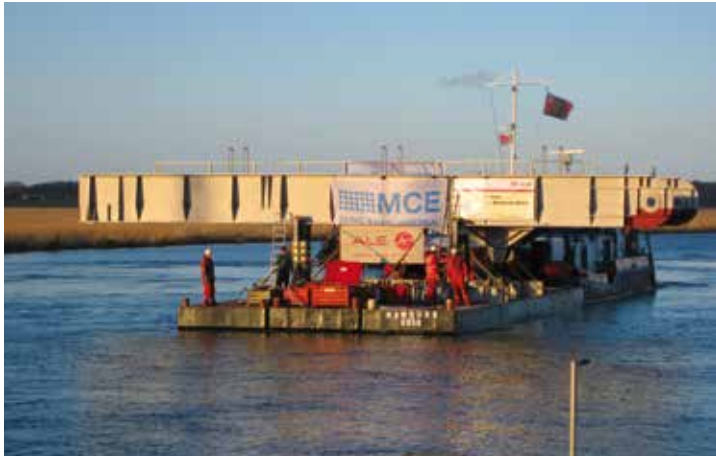
Einschwimmen der Klappbrücke
