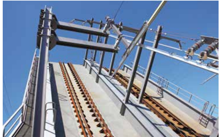
Klappbrücke in Hochlage
