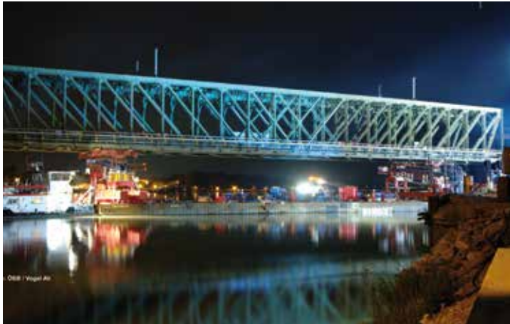
Demontage altes Tragwerk
